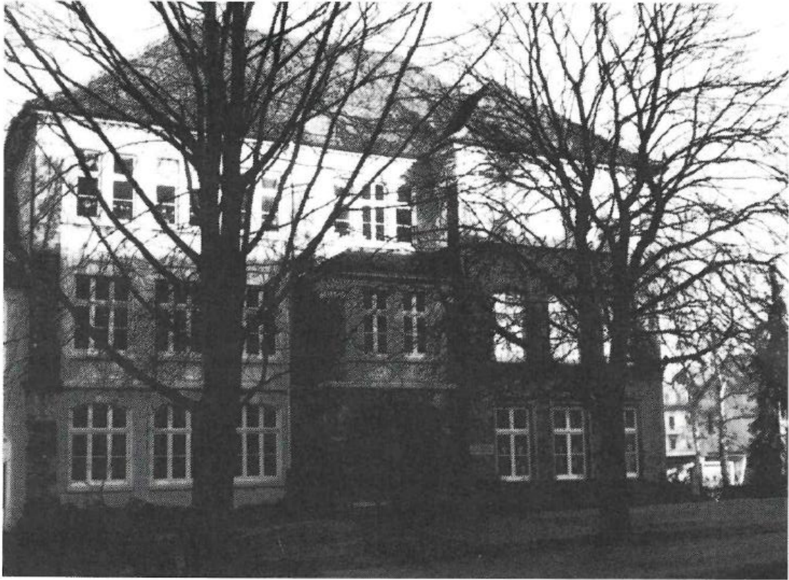
Neubau der Volksschule am Kirchplatz aus dem Jahre 1923 unter Einbeziehung des 1885 erbauten Ostflügels der Knabenschule.
